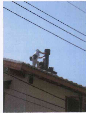
♪煙突の上部をつけて屋内へ
