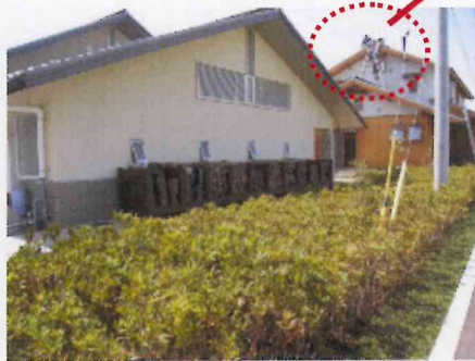
♪（薪置き場と）まず屋根に上ります。 瓦屋根・形状・勾配！業者泣かせです。
